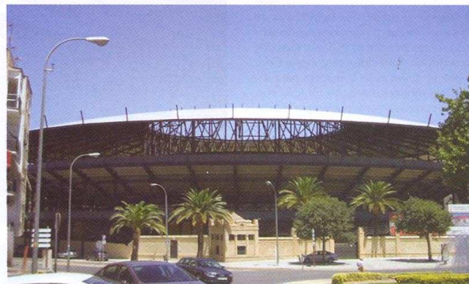
El acabado de la cubierta es con una lámina asfáltica recubierta de aluminio de color zinc
