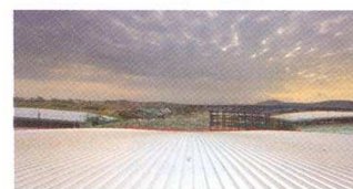
Cubierta realizada con el sistema Aczip
