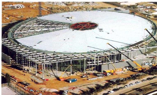
► Construcción de la cubierta del Palma Arena de Mallorca
