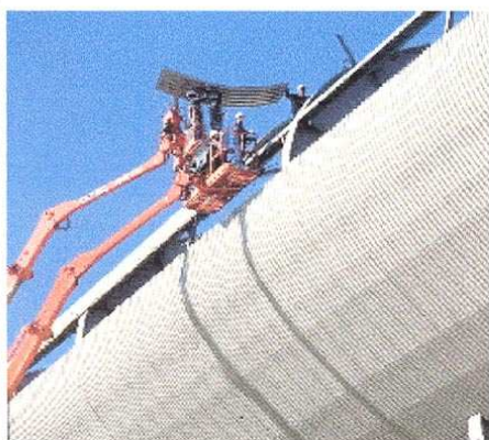
Montaje de una bandeja engatillada.
