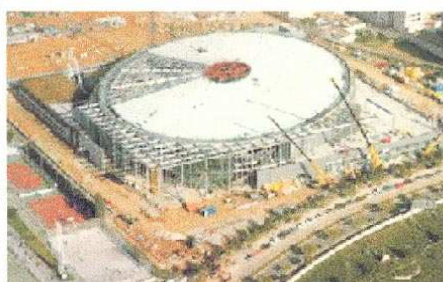
Obras del velódromo.
