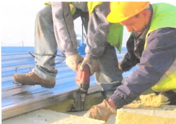
Técnicos instalan una cubierta "Acsol".
