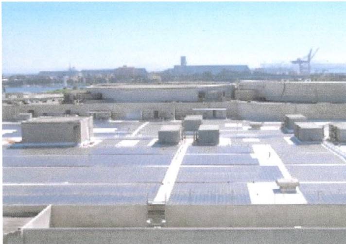
Instalación de una cubierta solar de Acieroid.
