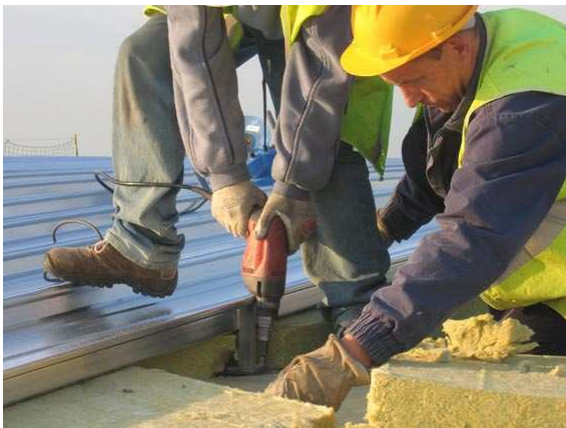
Técnicos instalando cubiertas solares ACSOL
